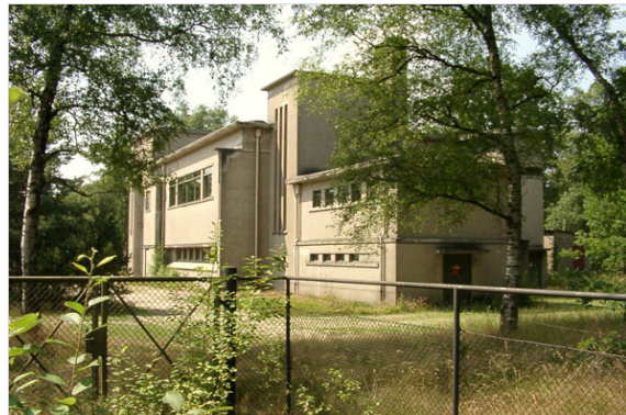
50 KV transformator Gebouw (foto: jwu)
