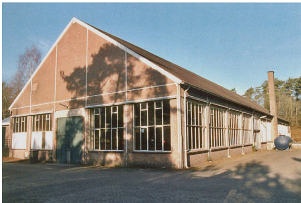
Gebouw G werkplaats (foto: cher)
