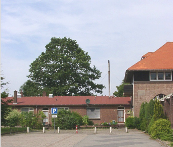
Woningen Radioweg 3, 5 en 7 tegen gebouw H (foto: jwu)
