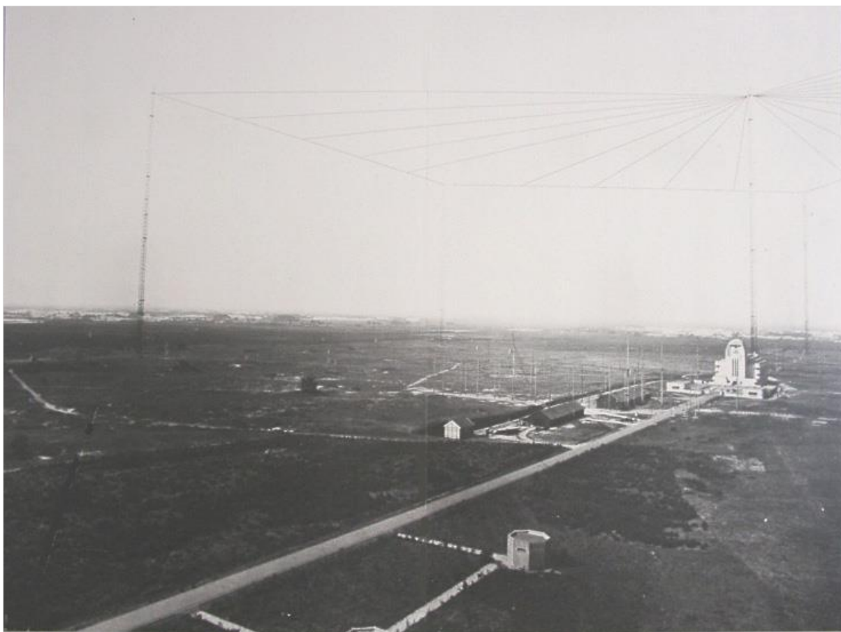
Lange golf Radio Zendstation Kootwijk met antenne en korte golf loodsen met antennes (foto: PTT)
