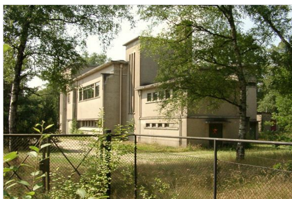
50 KV transformator Gebouw (foto: jwu)
