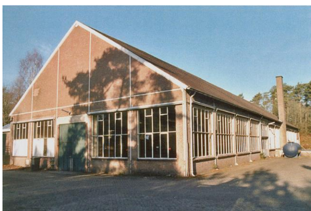
Gebouw G werkplaats (foto: cher)
