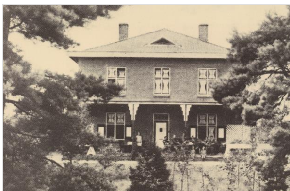
Gebouw F (directie gebouw) (foto: Tussen Zand en Zenders)
