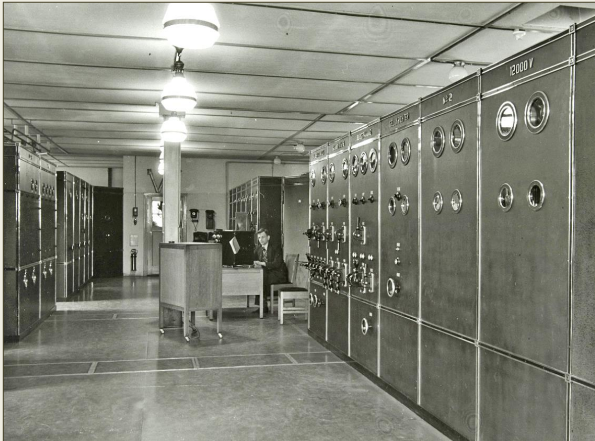
DE OMROEPZENDER MET EEN GOLFLENGTE VAN 1875 M EN EEN VERMOGEN VAN 120 KW
