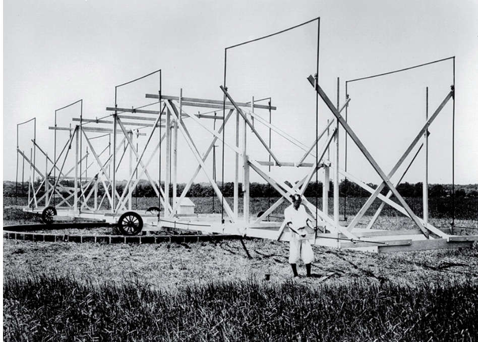
Zelfgebouwde draaibare antenne van Karl Jansky
