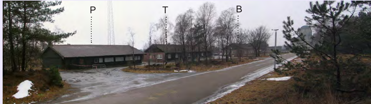
Situatie voorjaar 2010 inclusief loods B
