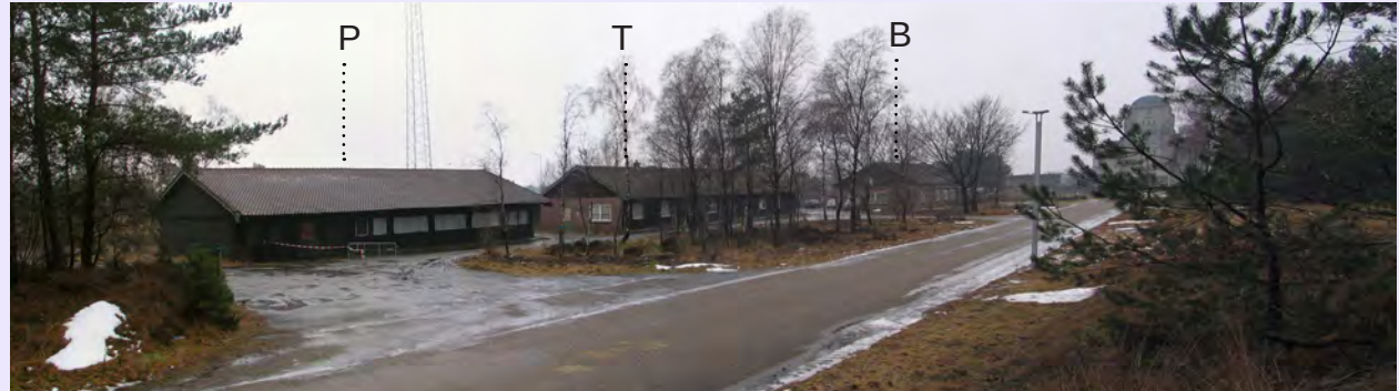
Situatie voorjaar 2010 inclusief loods B
