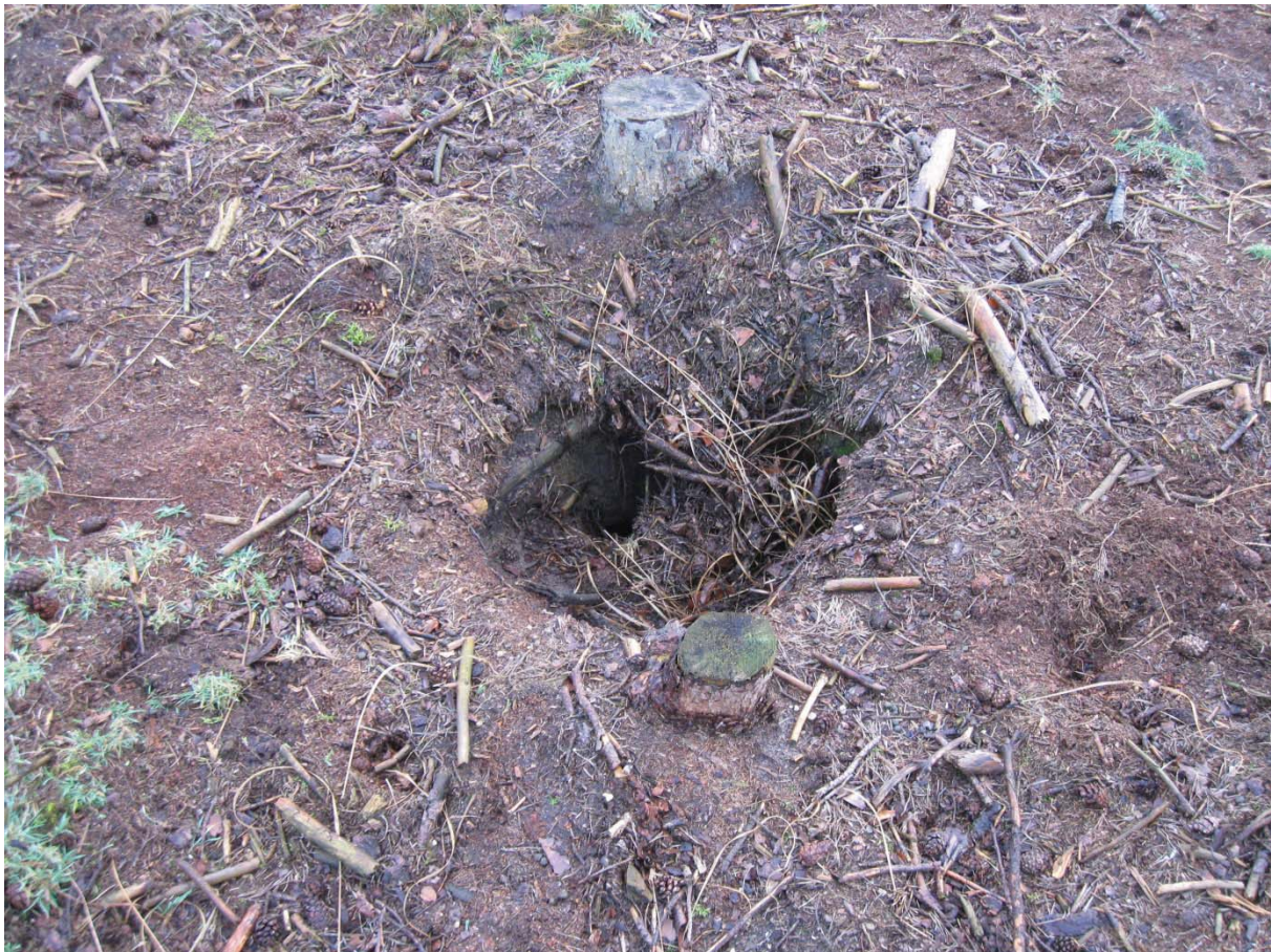
fig 3.2.3 ; Gat in de grond, nadat de bosbouwmachine een z.g. 'verdrijver' door de putdeksel is gezakt, is er metselwerk zichtbaar.
