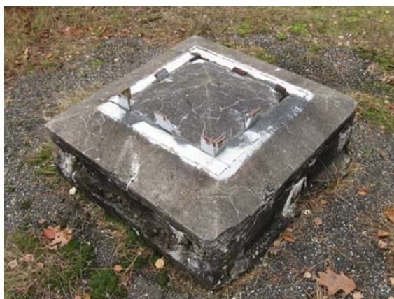
Afgezaagde vakwerkmast bij gebouw K
