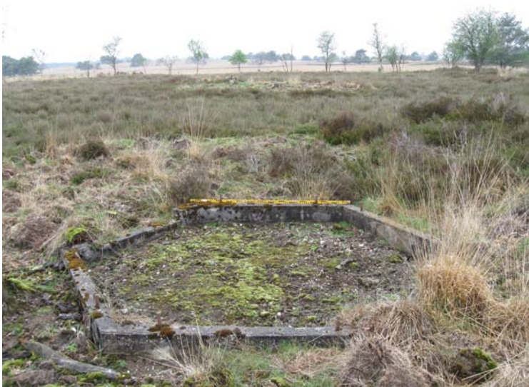
fundering koppelhuisje bij gebouw C
