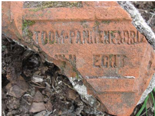
met cement aangestroken dakpan
