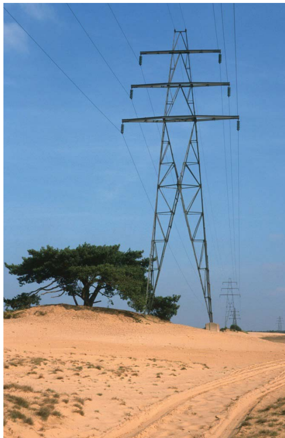
fig 5.1 ; Inmiddels gesloopte hoogspanningsmasten op het kootwijkerzand, let op het ontbreken van de traversebalken. bron; Tom Borger
