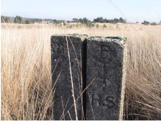
dubbele markeerpalen 'PTT HoogSpanning' langs de Burelhulweg
