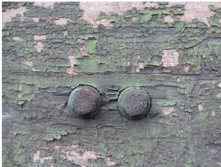
fig 4.2.1 ; Oorspronkelijke kleuren op de Utrechtse loods, gebouw T
