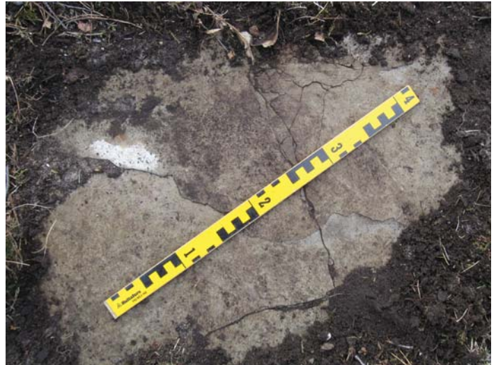
gietvloer nog in het veld aanwezig
