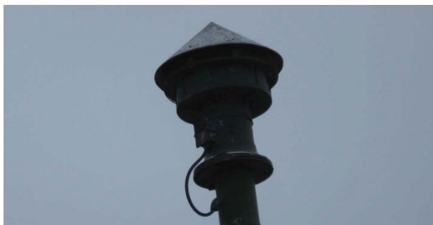
fig 4.1.2 ; Sirene voor gebouw D op het korte golf terrein
