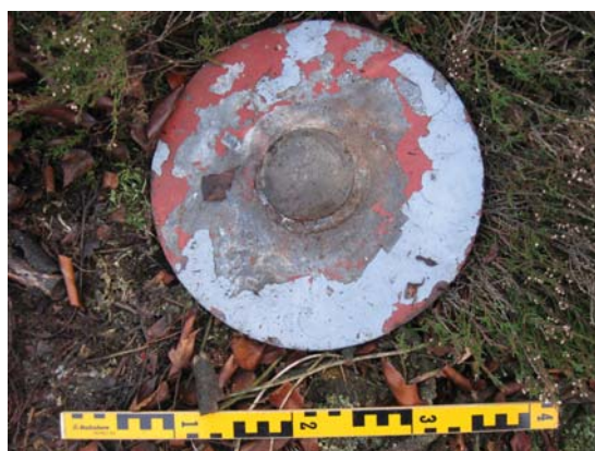
Kogelscharnier voor zendmast
