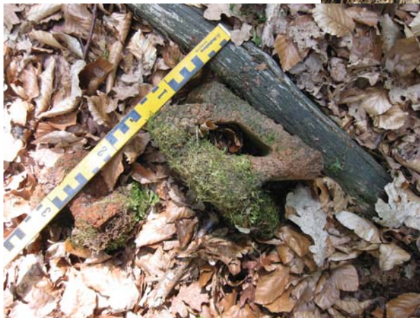
vormstenen van bimsbeton, met sporen van metselspecie.
