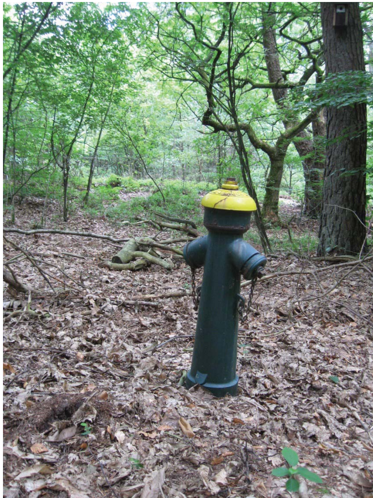
fig 4.1.3 ; Originele hydrant, fabrikant HOLLAND, Bergen op Zoom, aangesloten op het weer werkende watertoren netwerk langs het bospad tussen de conciërgewoning (Turfbergweg 2/3) en het afgebrande gebouw F
