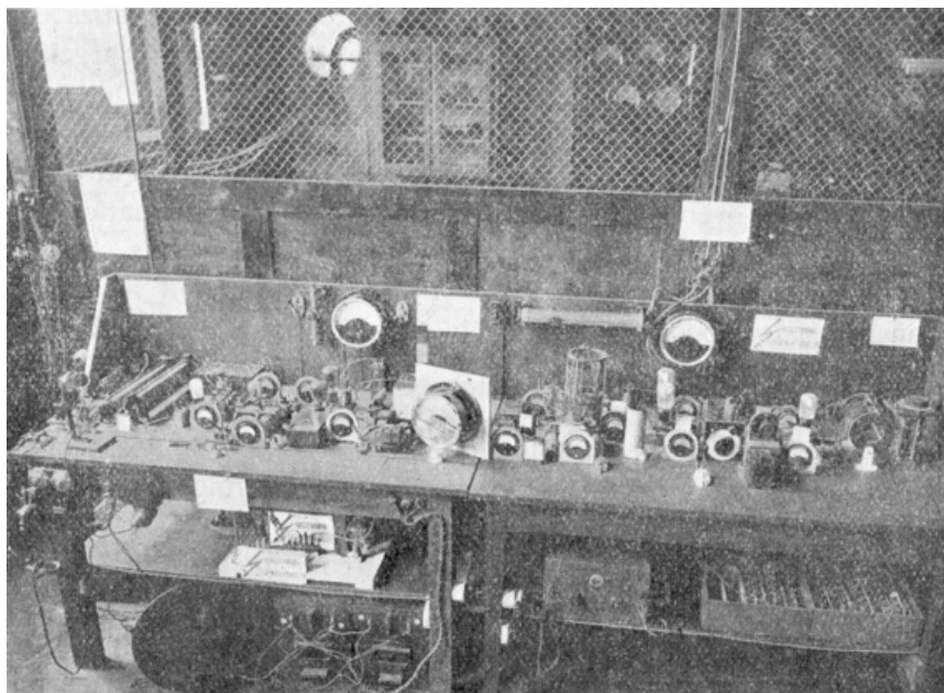
Fig. 1. Experimenteele telefoniezender met kristal gestuurd. Golflengte 90,56 m. De linksche tafel bevat versterkers en modulator; de rechtsche tafel het hoogfrequente deel.
