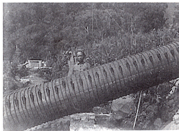
Afb.IX.5-2. Houten drukleiding met een doorsnede van circa 1 m naar de turbine van de waterkrachtcentrale [J3].
