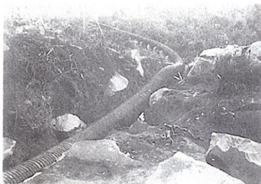
Afb.IX.5-2. Houten drukleiding met een doorsnede van circa 1 m naar de turbine van de waterkrachtcentrale [J3].
