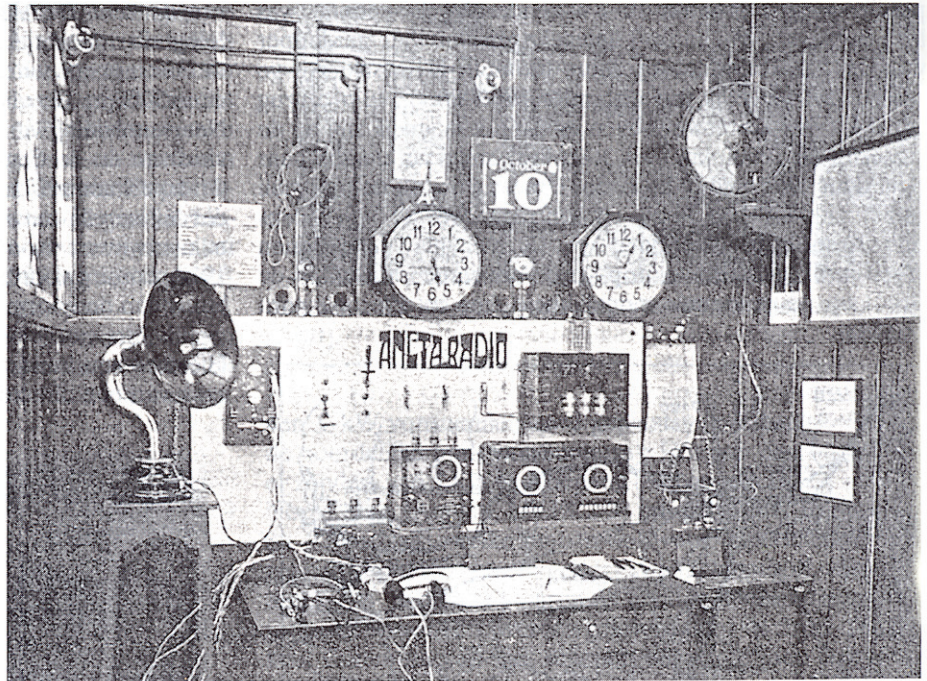
Afb.IX.4-3. Ontvanginstallatie voor perstelegrammen van ANETA te Weltevreden. De ontvanger is een Marconi-toestel met zes lampversterkers, één der meest geperfectioneerde uit die tijd. Met dit apparaat kon in de vroege ochtend in de VLF-band worden ontvangen de stations Leafield, Bordeaux, Nauen en Eilvese. Er werd wel storing ondervonden van de zender te Malabar [J5]. (VLF = Very Low Frequency)
