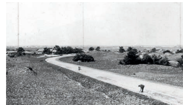
De weg ernaar toe in aanleg.
